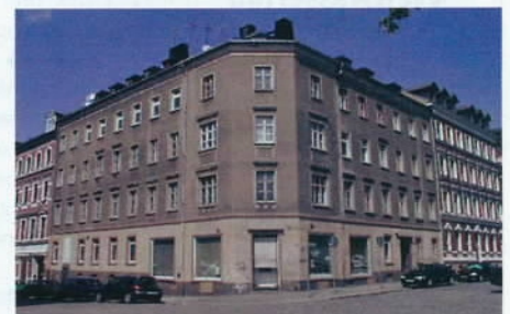
Die Uhlandstraße 1 soll ein Wächterhaus werden. Fotos: Agentur StadtWohnen-Chemnitz
