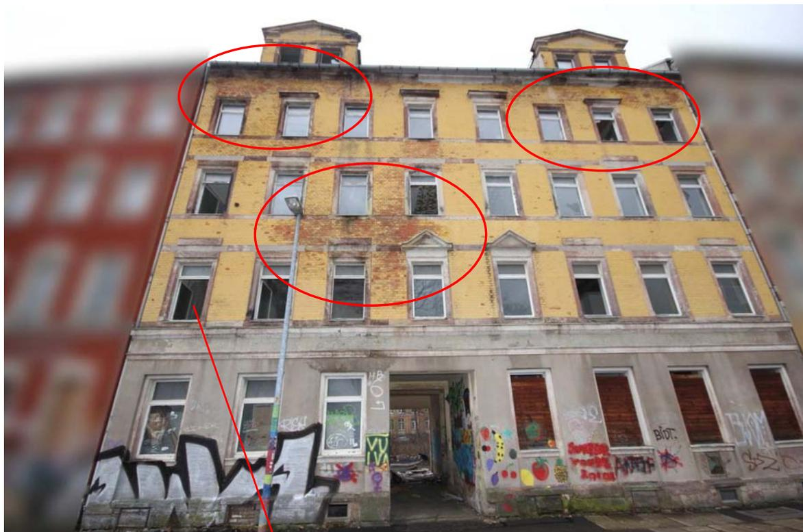
Durchfeuchtung der Decke zwischen 1. und 2. Obergeschoss
