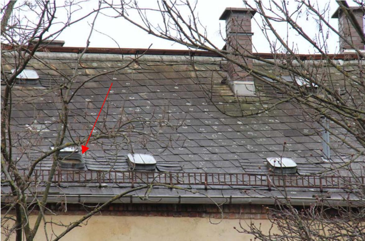
Dacheindeckung zur Hofseite mit Dachplatten aus Asbestzement; offene Dachluke ermöglicht Eindringen von Niederschlag (Pfeil)
