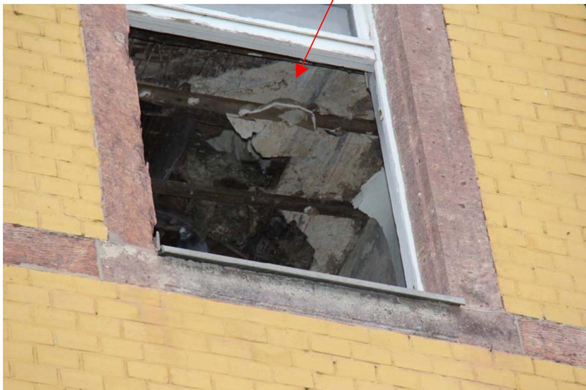
durchgebrochene Decke zwischen 3. Obergeschoss und Dachgeschoss
