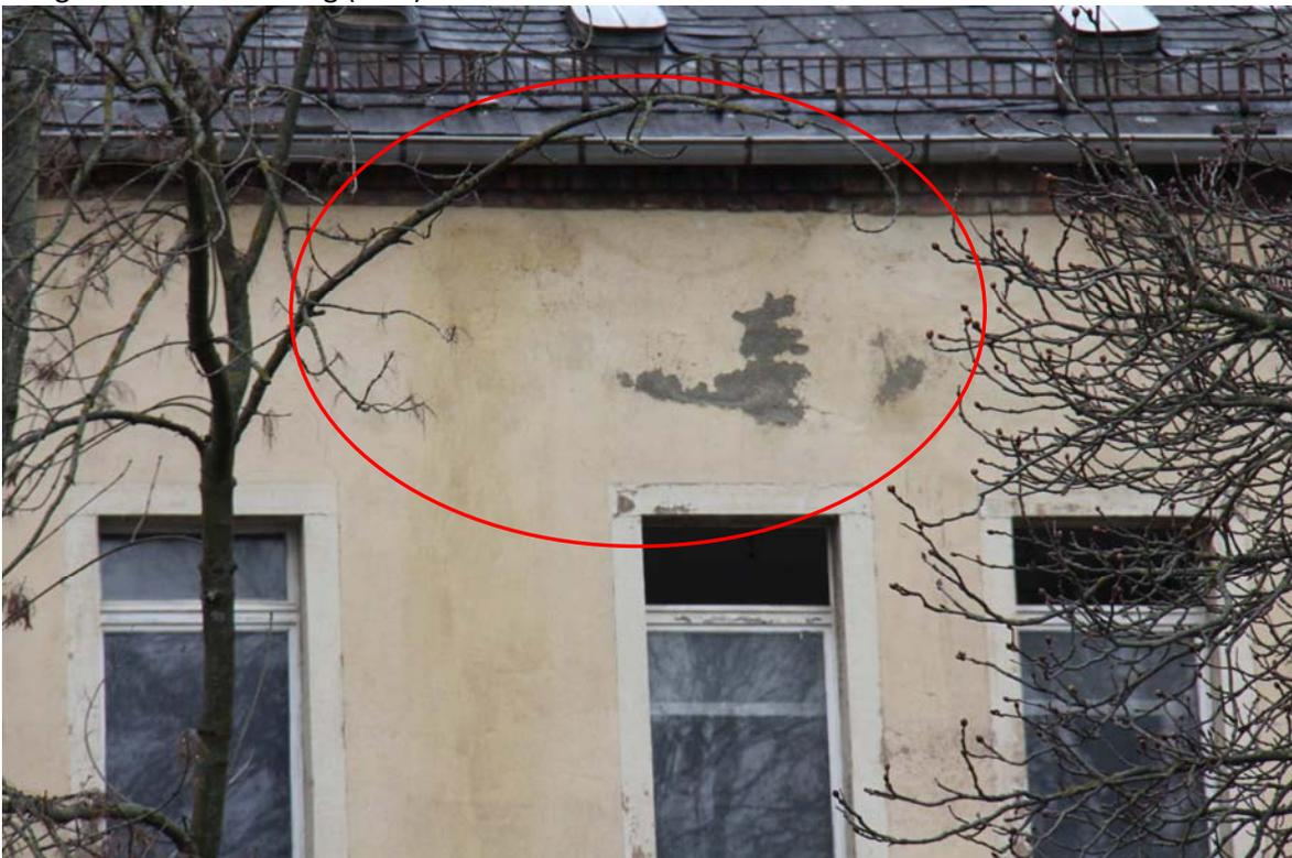
Hoffassade; Verfärbung (Durchfeuchtung) im Bereich 3. Obergeschoss und Dachgeschoss
